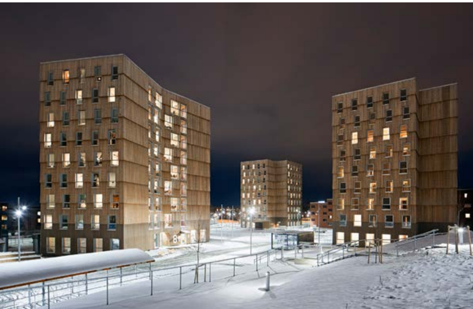
Bilde: Moholt 50|50 studentboliger, Trondheim Bygges som passivhus i massivtre MDH Arkitekter as Foto: Ivan Brodey
