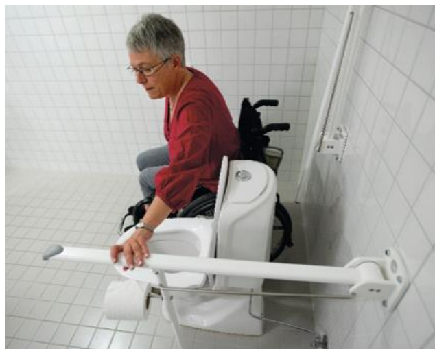
Veggmontert toalett med støttehåndtak montert på vegg og gulvplass på 20 cm fra vegg til bakre cisternekant, som gjør sideveis forflytning fra rullestol enklere og gir plass til hjelpers fot. Det mangler kontrast mellom utstyr og vegg og mellom gulv og vegg. Kilde: Toalett og bad. Detaljer som teller. Norges Handikapforbund. Foto: Marit Hommeland
