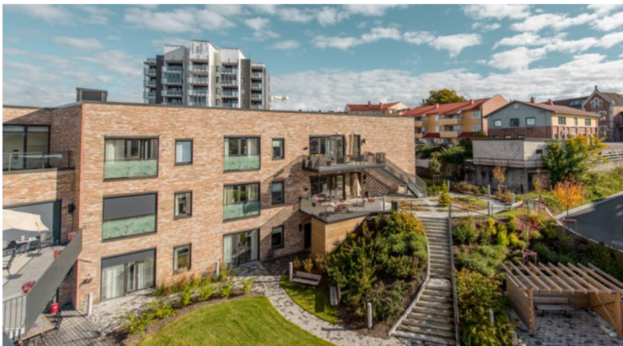
Skoggata bo- og servicesenter ligger i Moss sentrum med kafeteria åpen for alle. Prosjektet er integrert i et vanlig bomiljø. Utearealene er attraktive og brukes også av folk fra nabolaget. Mer om prosjektet på arkitektkontorets nettside via denne lenken . Foto: Norlandia.no
